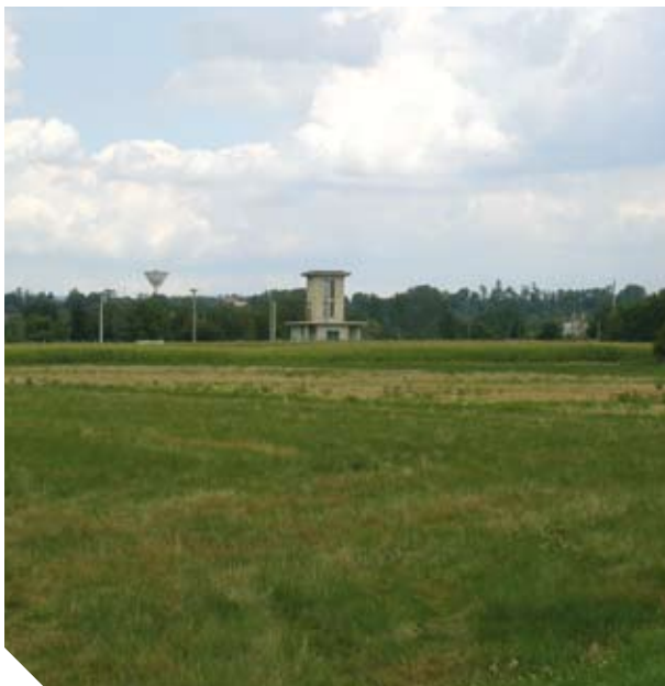
Captage d'eau potable dans la nappe de la Valloire à Manthes (© CLE SAGE Bièvre-Liers-Valloire).
